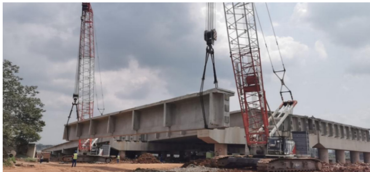
■ 老旧桥梁改造利用（T 梁保护性吊装）
